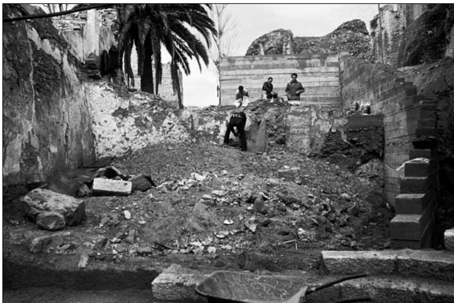
Fig. 7. Detall del solar de la Costa dels Capellans, un cop enderrocat el vell edifici que hi restava i construït el mur pantalla de formigó.
