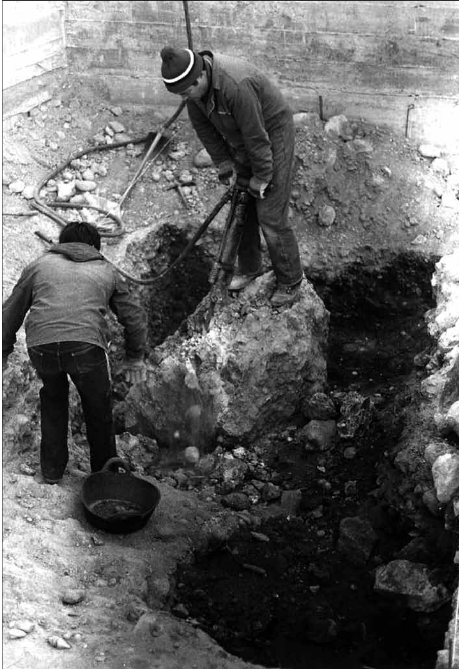
Fig. 16. Treball d'eliminació del bloc de conglomerat per finalitzar l'excavació.
