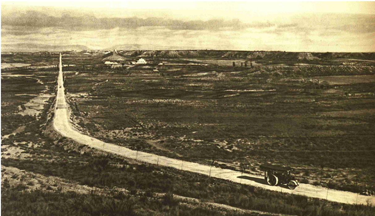
(Fig. 2) Construcción de la carretera de Gimeneles a Almacelles, al fondo, sobre la recta y apoyado en la colina se construirá el pueblo de Sucs. Fuente: Archivo Histórico de Lleida.
