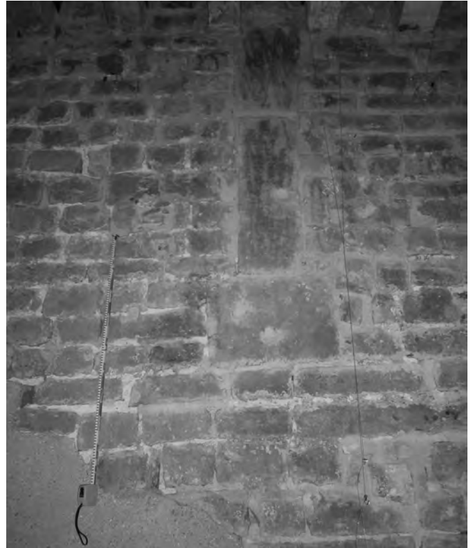
Figura 7 Detall d'una cadena vertical en l' opus africanum localitzat al Pati d'en Llimona. [Fotografia: A. Ravotto]
