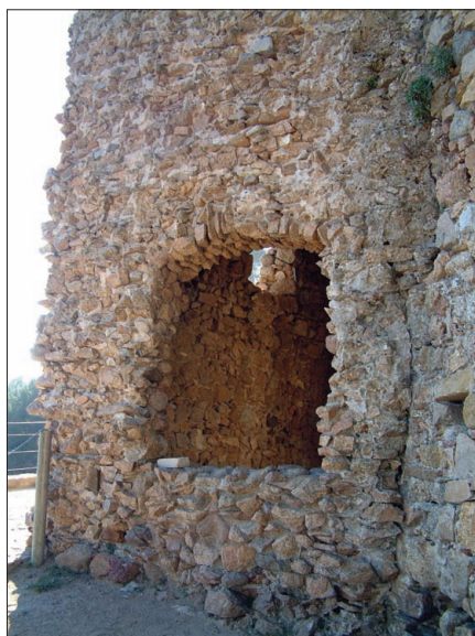
Fig. 18. Parte exterior de la sacristía.
