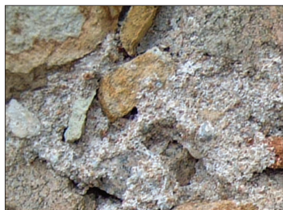
Fig. 21. Alteraciones cromáticas debidas a óxidos de hierro (limonitización).
