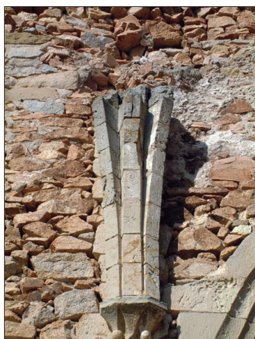
Fig. 2. Arranque de las nervaduras de las bóvedas.
