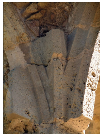
Fig. 26. Fracturas originadas por desequilibrio estructural.
