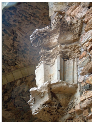
Fig. 24. Formación de alvéolos y cavernas.
