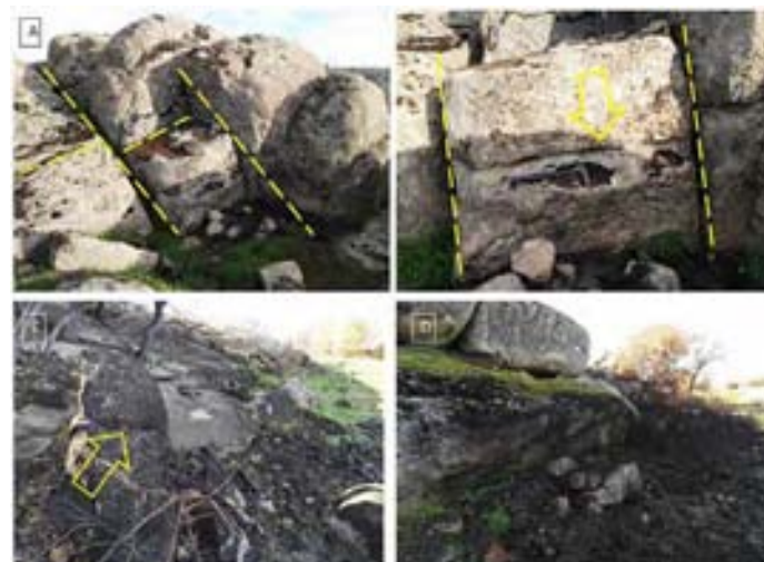
FIGURA 11. ÁREA NE, SECTOR N. A: FAMILIAS DE DIACLASAS ORTOGONALES, B: ESPACIADO ENTRE DIACLASAS (2 M), EMPLEO DE CUÑAS PARA LA DIVISIÓN DE LOS BLOQUES EN LA DIRECCIÓN HORIZONTAL, LOS CORTES VERTICALES Y EL TAMAÑO DEL BLOQUE QUEDAN DEFINIDOS POR LAS DISCONTINUIDADES, C: SECTOR N PERIFÉRICO. IMPRONTAS DE CUÑAS PARA LA EXTRACCIÓN DE BLOQUES, D: FRENTE DE EXPLOTACIÓN. Fotos: los autores
