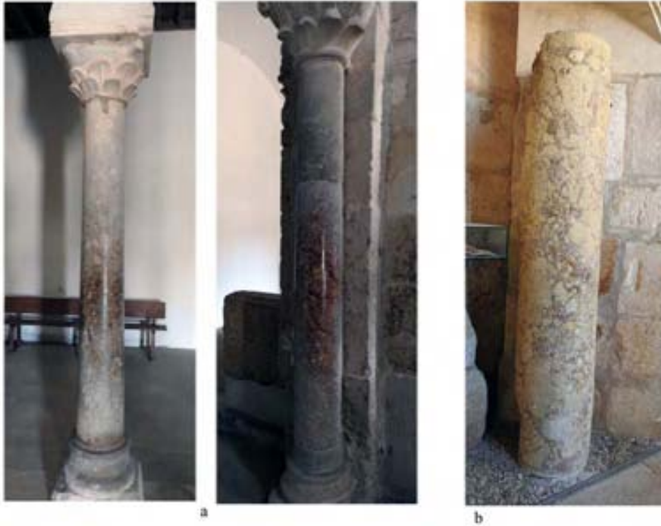
FIGURA 19: FUSTES DE COLUMNA EN VARIEDAD CONGLOMERADO. A: SAN MIGUEL DE ESCALADA; B: COLEGIATA DE COVARRUBIAS. (Fotos: Virginia García-Entero)
