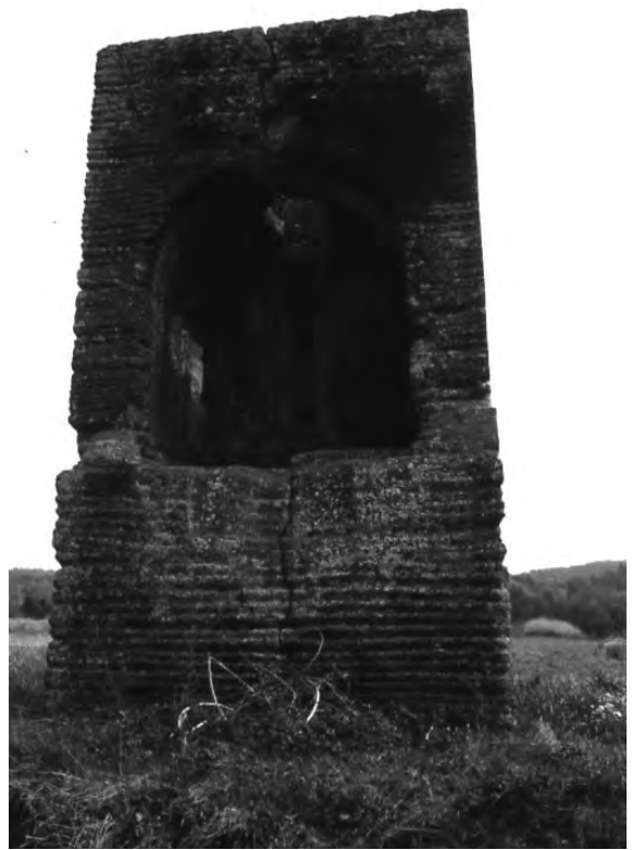
Figura 5. La Torratxa (Vilablareix). Tomba monumental associada a la vil·la suburbana. Exemple de voluntat de ser enterrat in suo fundo .
