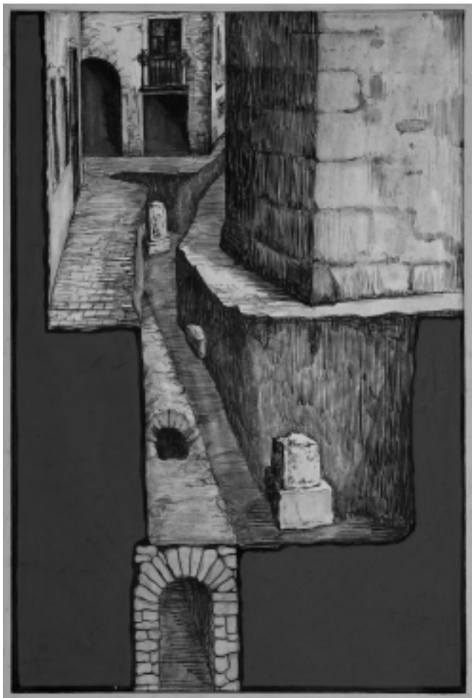
Figura 14 Secció de l' aquae ductus del carrer de la Palma de Sant Just. (Dibuix: Josep Gudiol. Centre de Documentació-MUHBA)
