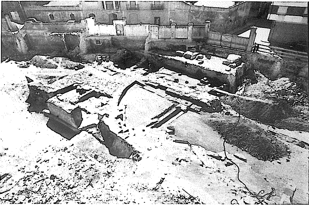
Fig. 3. Restos arrasados del teatro de Tarraco en 1977. Vista lateral mostrando el corte del proscaenium y la cimentación de la frons scaenae por un enorme depósito anexo (Dossier Teatre 1977-1979).
