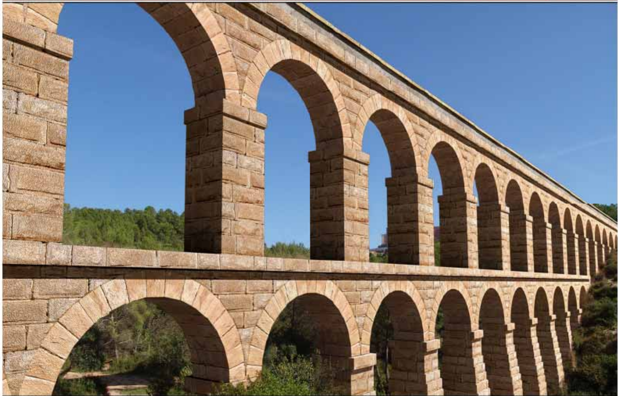
RESTITUCIÓ DE L'AQUÈDUCTE DE LES FERRERES (JLS)
