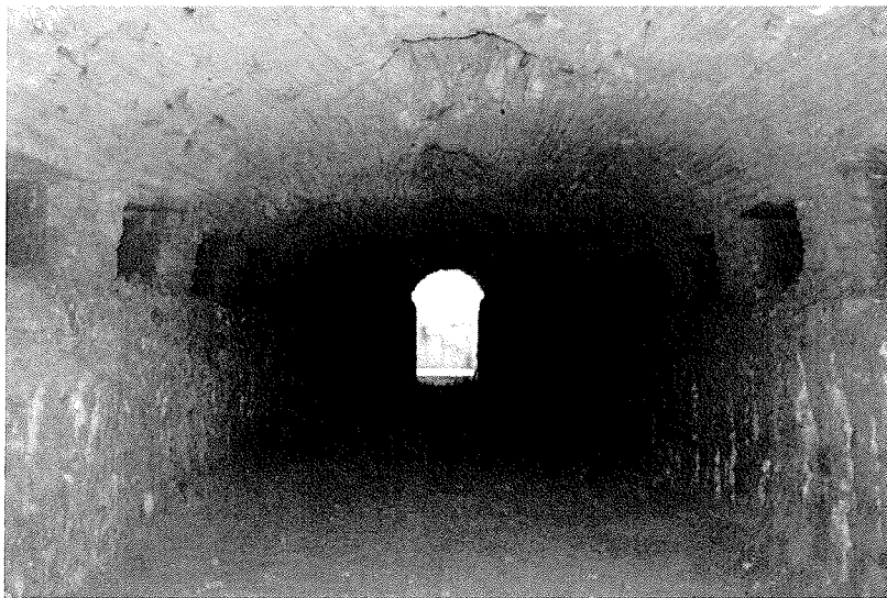
Figura 11: Detall de la galeria un cop buidada.
