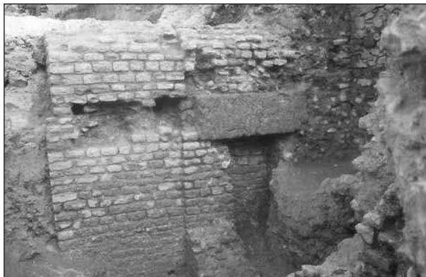
fig. 69: Detall frontal de les estructures 22/14 amb la porta 149 i el paredat 159
