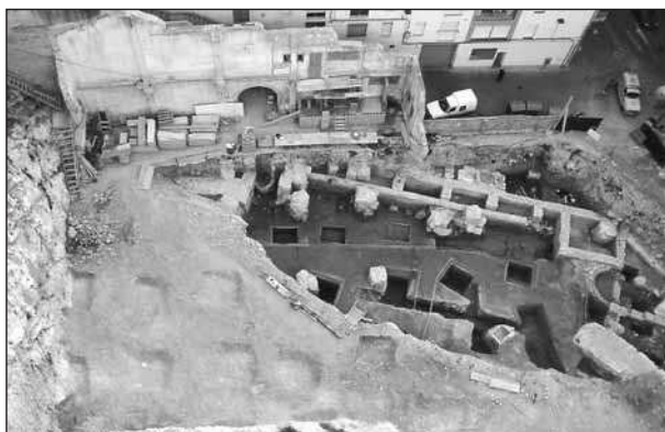
fig. 68: Vista general de l'excavació amb els fonaments del nou immoble
