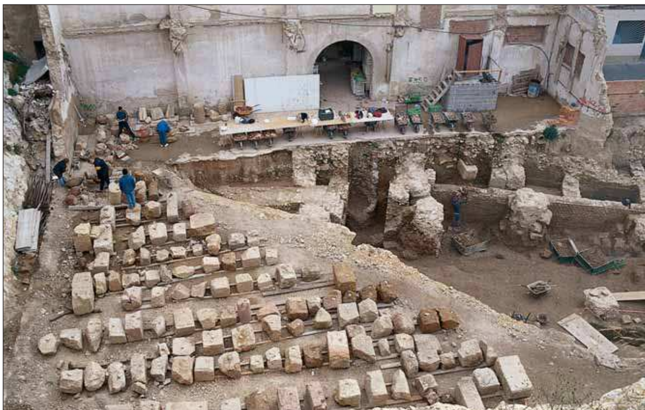
fig. 86: Procés de recuperació i d'estudi del material constructiu
