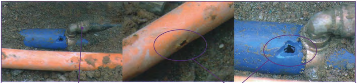
Acometida de agua al edificio
