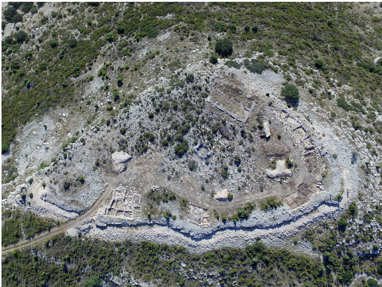
Figura 5. Vista oeste de las estructuras defensivas del fortín.
