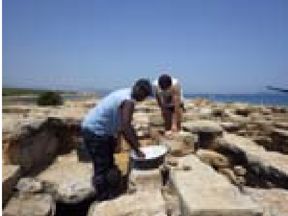
FOTO 477. Tasques de recol·locació amb morter de calç
