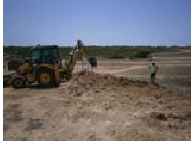
FOTO 56. Feines realitzades: control de la retroexcavadora i anivellament de la banda sud-oest del jaciment.
