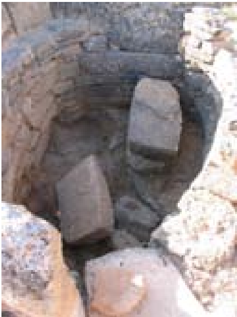
FOTO 19. Desperfectes causats a T84, restaurada a la intervenció de 2012.
