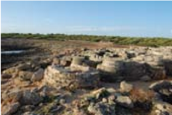
FOTO 66. Estat previ. S'observa el creixement de vegetació damunt les estructures i voltants.
