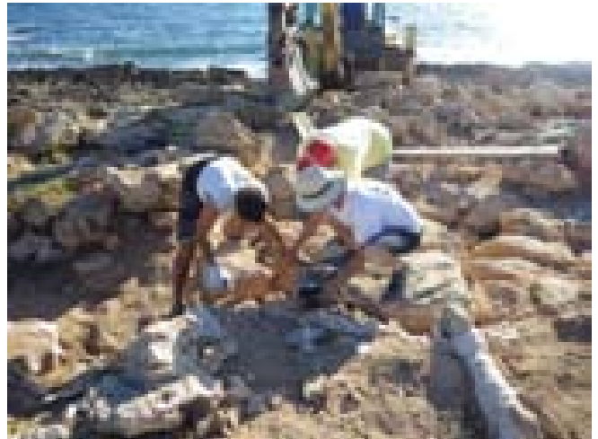
FOTO 497. Restauració de la Tomba 135: identificació de les posicions correctes de les pedres amb l'ajuda de la documentació fotogràfica.
