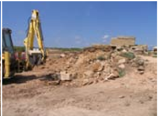
FOTO 28. Feines realitzades: desmuntatge del mirador amb retroexcavadora mixta.
