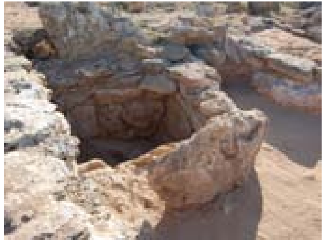
FOTO 465. Sector nord-oest. Estat final de T105: gràcies a la documentació prèvia existent, s'ha aconseguit identificar les pedres i lloses caigudes i recol·locar-les. N'ha calgut enganxar algunes, ja que es trobaven fragmentades.
