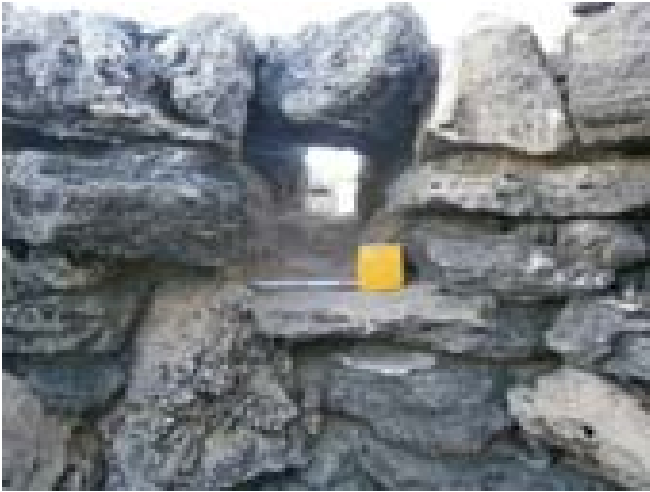
FOTO 423. Excavació i documentació: T3, amb la finestra oberta, per l'interior.
