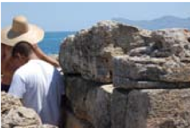
FOTO 444. Detall del parament sud de T67, un cop restituint el bloc.
