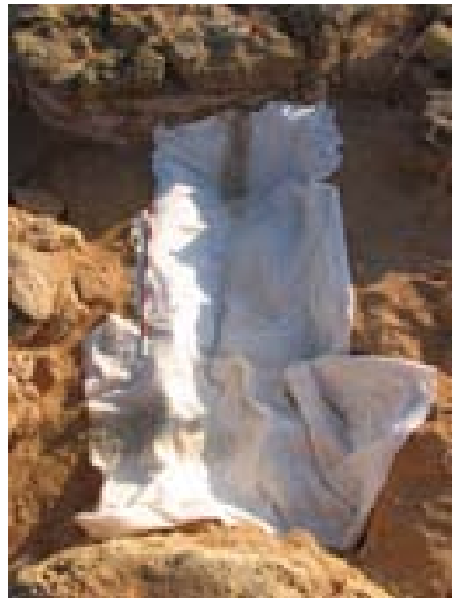
FOTO 177. Sector nord-oest. Rasa tapada amb geotèxtil.
