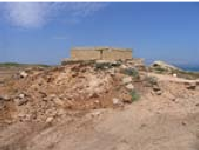
FOTO 27. Feines realitzades: evacuació de la terrera/acumulació de terres a la banda sud-oest del jaciment.
