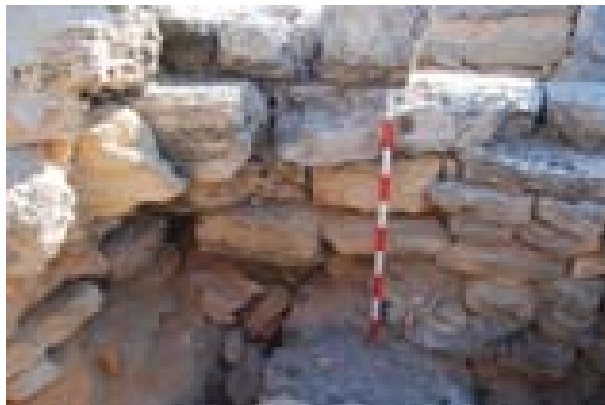
Fig.5. Fotografia final. Vista parament nord-oest, interior.
