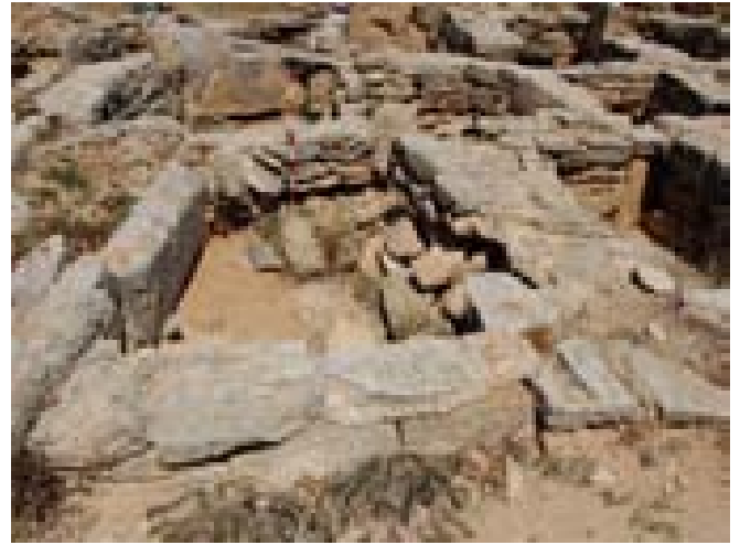
FOTO 459. Sector sud-est. Fotografia de T98, que il·lustra les patologies generals de les tombes en bateria del sector sud-est. Es pot observar la manca de fonaments i la pèrdua completa de paraments interiors, així com la inestabilitat de les crestes.
