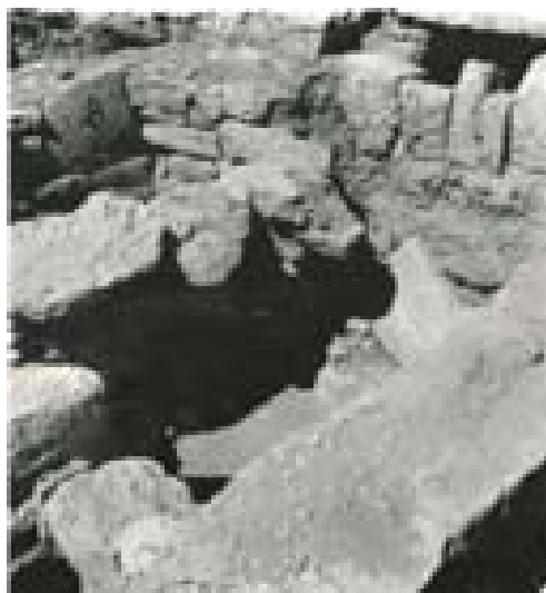
Fig.8. Vista del parament nord i oest.
