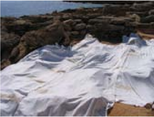
FOTO 214. Sector T47-T87. Geotèxtil.
