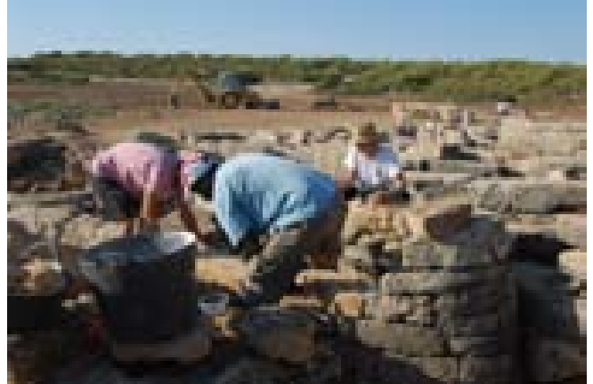
FOTO 482. Feines realitzades: consolidació i restauració. Restitució de blocs.
