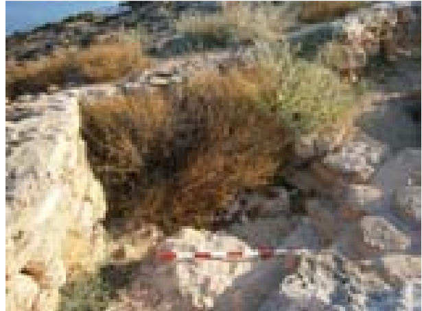
FOTO 44. Estat previ. S'observa el creixement de vegetació damunt les estructures.
