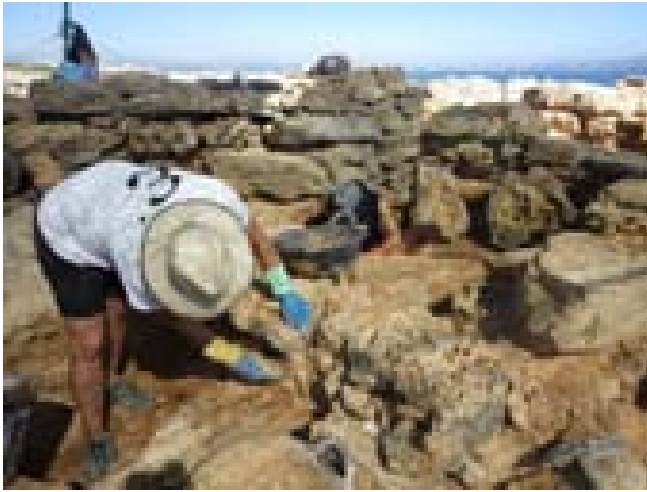
FOTO 490. Restauració del sector T48-62: consolidació amb morter de calç de les estructures.
