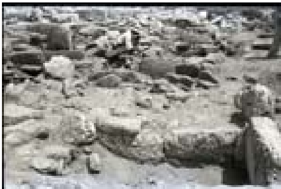
Fig.8. SRAT. 1967. Vista en procés d'excavació.
