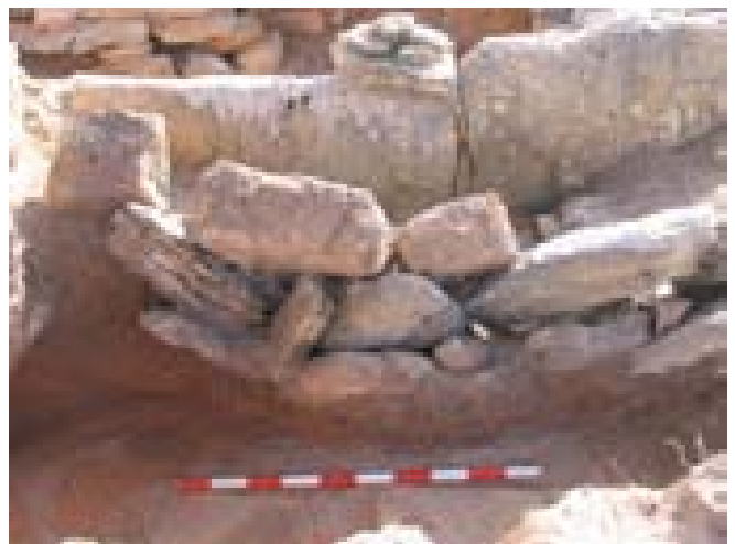
FOTO 457. Sector sud-est. Detall del mur nord-est de T100. S'hi aprecia el venciment i dislocació del parament.
