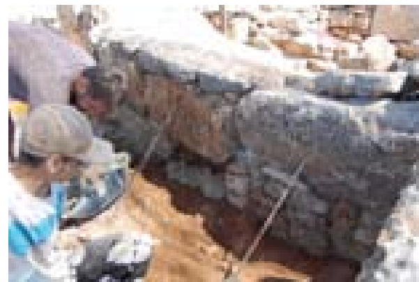
Fig.6. Fotografia procés de realització de fonaments.
