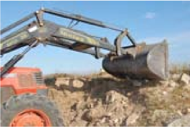
FOTO 5. Actuació de la pala carregadora a la terrera sud-oest.
