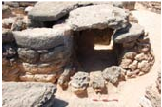
FOTO 442. Vista de T57 i T56 una vegada finalitzades les tasques de consolidació
