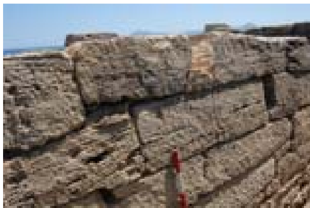
Fig.7 Fotografia final. Vista parament sud-oest.
