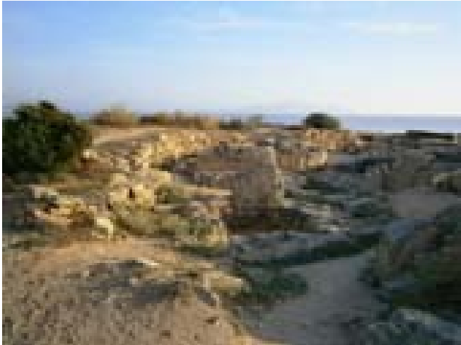
FOTO 29. Estat previ. S'observa el creixement de vegetació damunt les estructures i voltants.
