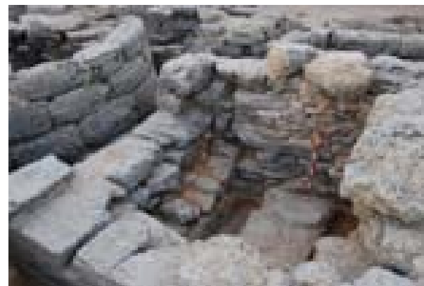
Fig.12. Fotografia procés. Vista parament sud-oest
