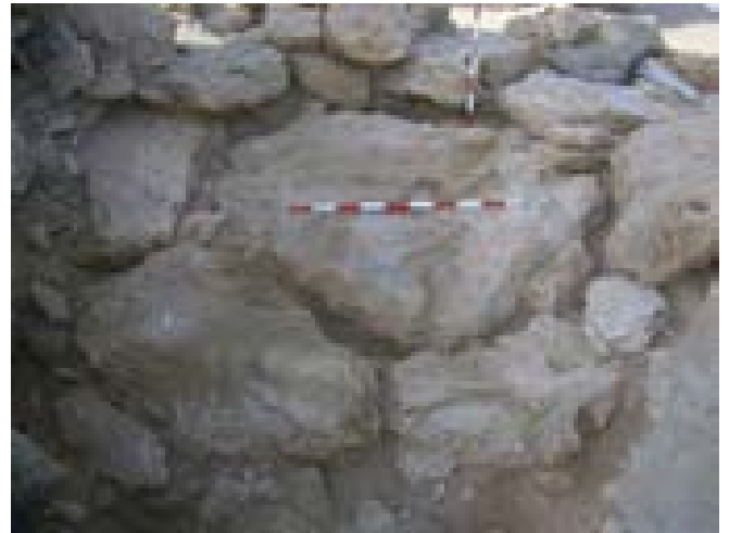
FOTO 347. Sector T106-114. T133. Rebles constructiu UE 1604 damunt i al voltant de la llosa de coberta UE 6.
