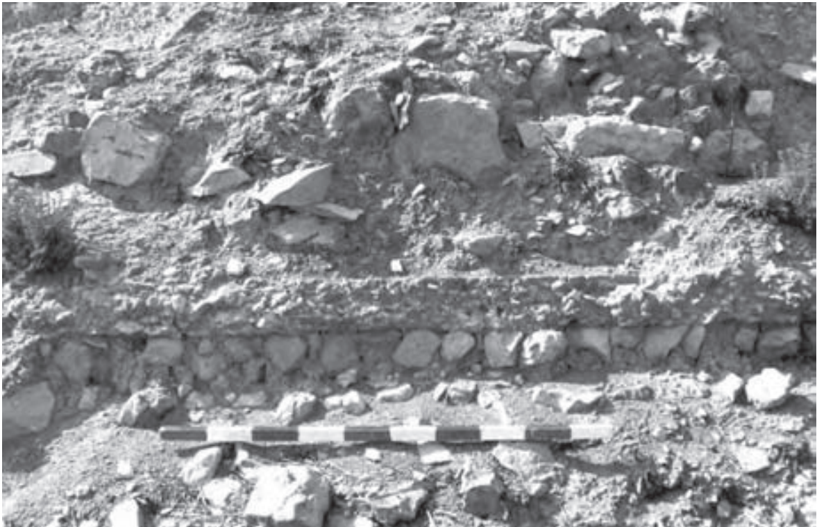
Figura 4. Secció de paviment d'un gruixut opus testaceum sobre un llit de pedres en un tall d'erosió del jaciment de la Fogonussa (fot. M. Torres).
