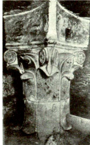
Figura 3.4. Fotografía, anterior a 1920, de los dos capiteles contrapeados con el añadido superior de 1599 para depositar la lipsanoteca. Arxiu Capítular de Barcelona.
