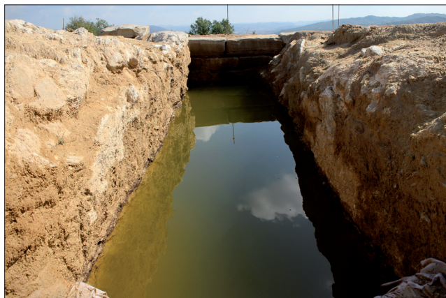
Fig. 6. Interior de la cisterna.
