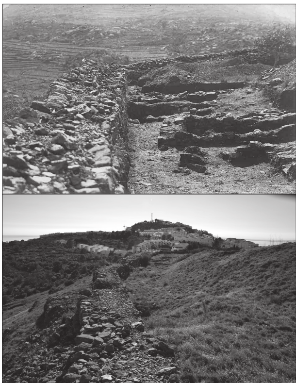
Figura 4. Detall de l'estat d'abandonament del sector de llevant de la muralla abans dels treballs de desenrunament. La foto antiga correspon al mateix sector tal com es va deixar l'any 1917 (fot arxiu MAC-Girona).
