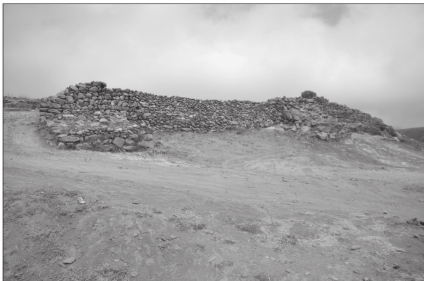
Figura 8. Imatge de la façana de migdia del recinte emmurallat després del desenrunament portat a terme durant el bienni 2014-2015.
