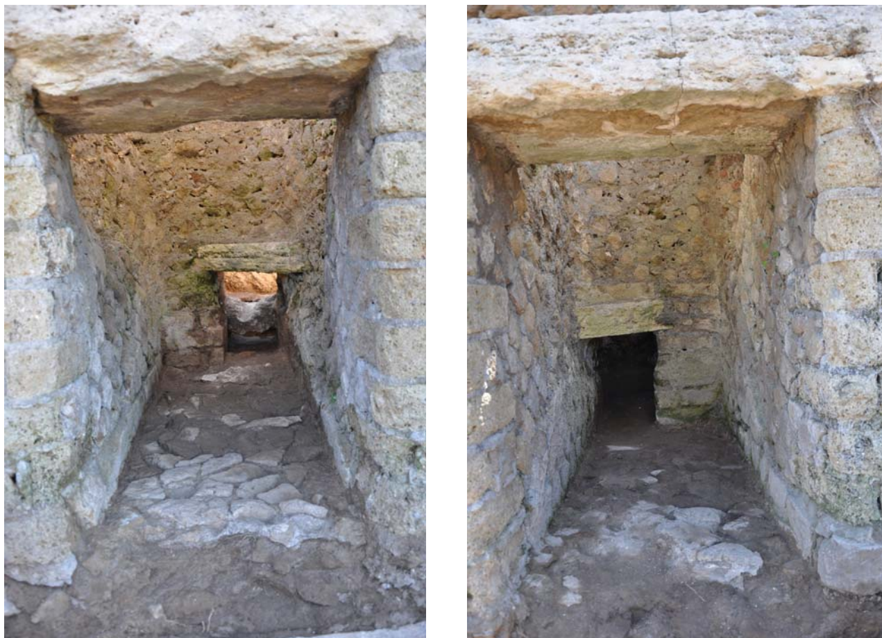
Figura 12B. Canal de desagüe de las letrinas. Desagüe interior de las letrinas este (izquierda) y oeste (derecha).
