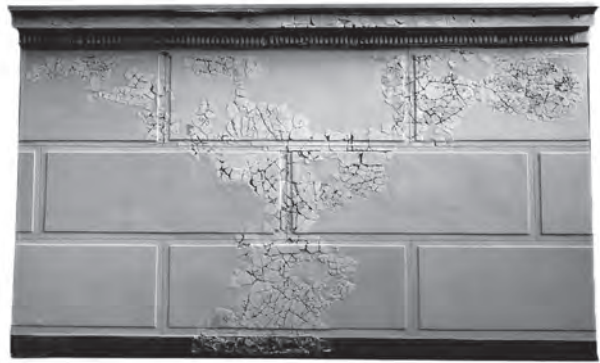
8. Can Tacó (Montmeló/Montornès del Vallès, Barcelone). Restitution du décor mural provenant de la pièce 5b (restauration D. Iglesias et I. Parra ; cliché J. Guitart).
