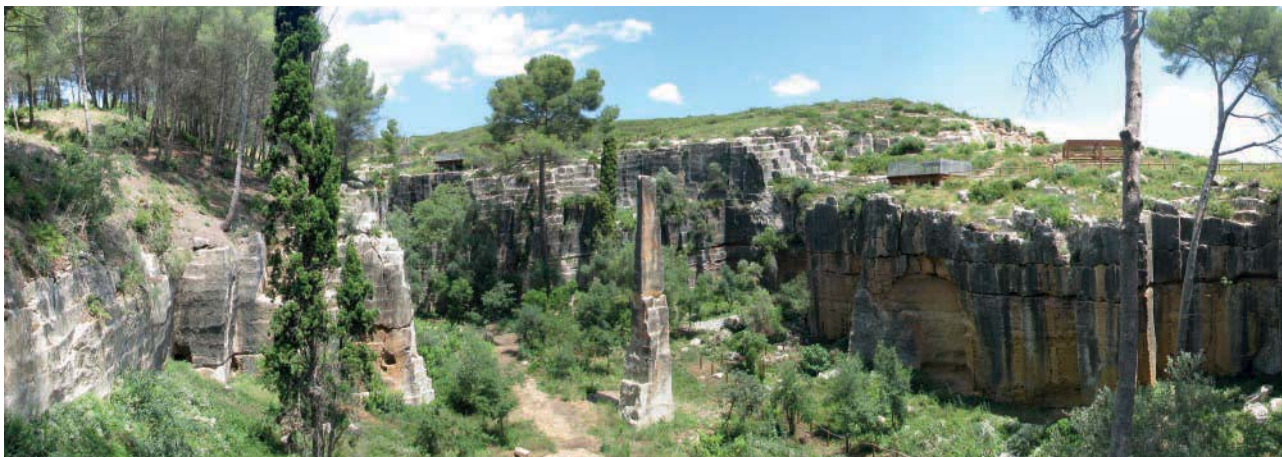
Figura 1. Vista de la parte o “sala” meridional del Clot con el pináculo central, en El Mèdol (foto: A. Gutiérrez García-M.)
