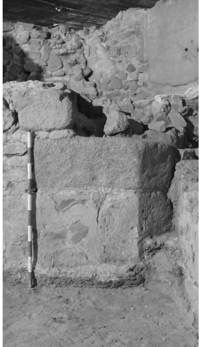
Figura 4 Cadena cantonera exterior de l'octògon. [Fotografia: Ramon Coll]
