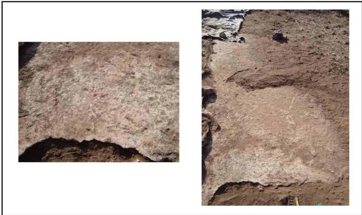
Fig. 5. Detalles del pavimento donde se realizaron las distintas catas de limpieza
