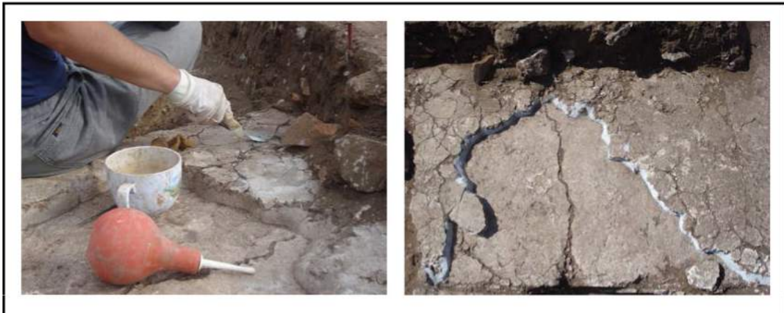
Fig. 3. Proceso de adhesión de fragmentos mediante la aplicación de mortero (izq.) Fragmento A, aplicación del reborde de protección (der.)
