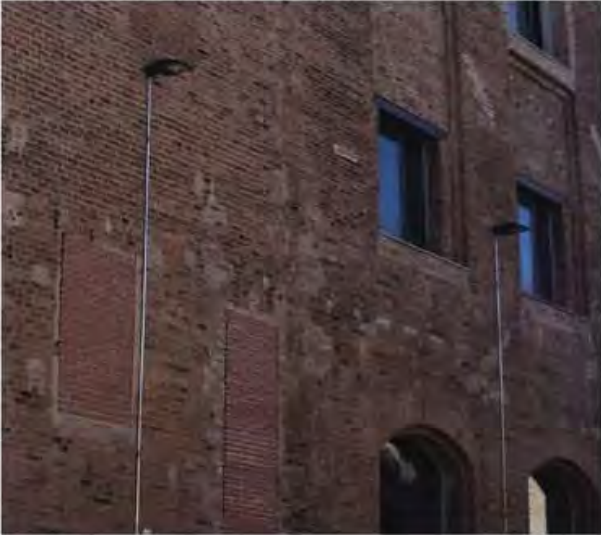
DETALLE DE MUROS EN EL PROYECTO "HABITATGES AL PASSATGE DEL SUCRE"
