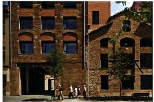
FACHADA POR LA CALLE RAMÓN TURRO.
