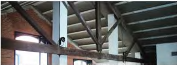
CERCHA DE MADERA EN UNA VIVIENDA TIPO "NAVE" DEL PROYECTO "PASSATGE DEL SUCRE"
