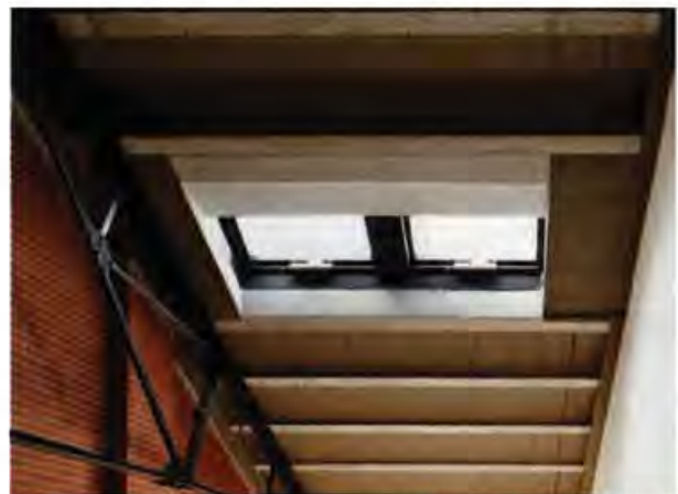
VENTANAS EN LAS CUBIERTAS DE LAS VIVIENDAS DEL PROYECTO "HABITATGES AL PASSATGE DEL SUCRE"
