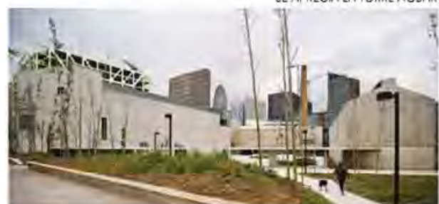
VISTA DEL PROYECTO MUSEO CAN FRAMIS DESPUÉS DE LA REHABILITACIÓN.
