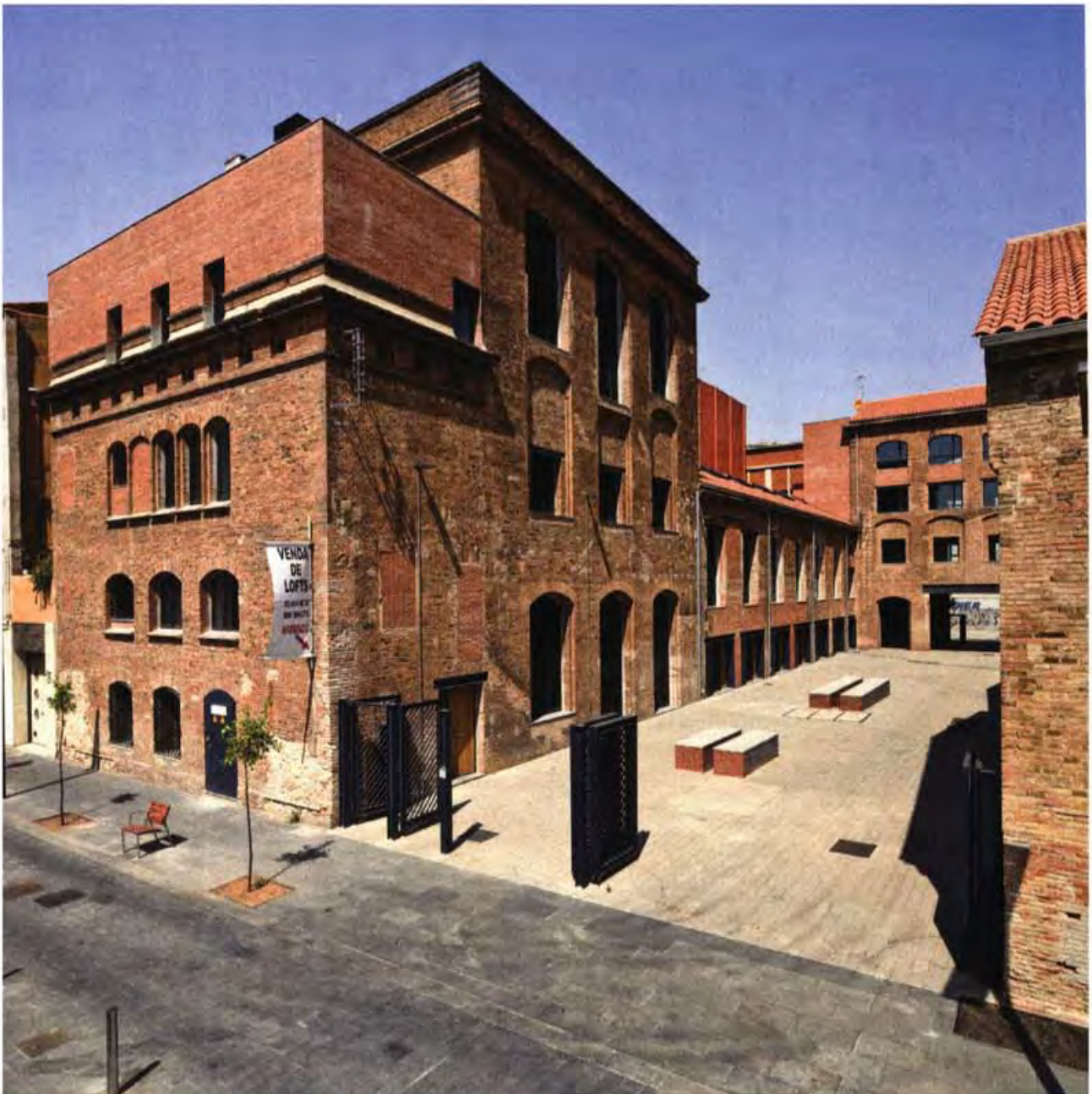
FOTOGRAFÍA DESDE EL ACCESO PRINCIPAL EN EL PASAJE MAS DE RODA HACIA EL INTERIOR DEL RECINTO, SE PUEDE APRECIAR TODO EL PASAJE CENTRAL QUE ABRE LA COMUNICACIÓN HASTA LA CALLE RAMÓN TURRÓ.
