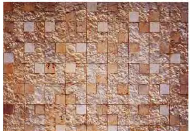
DETALLE DEL RECUBRIMIENTO DE UNO DE LOS MUROS EN EL MUSEO DE CASTELVECCHIO, EN EL CUAL SE MEZCLAN TEXTURAS, TAMAÑOS Y COLORES DE DOS MATERIALES
