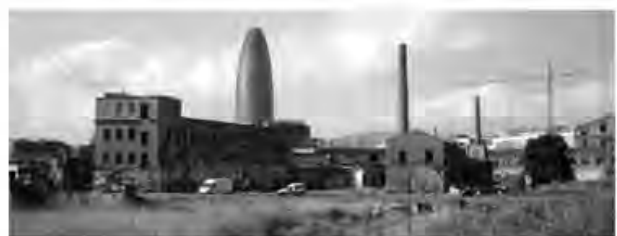
VISTA DE LAS NAVES ORIGINALES DE CAN FRAMIS, AL FONDO SE APRECIA LA TORRE AGBAR
