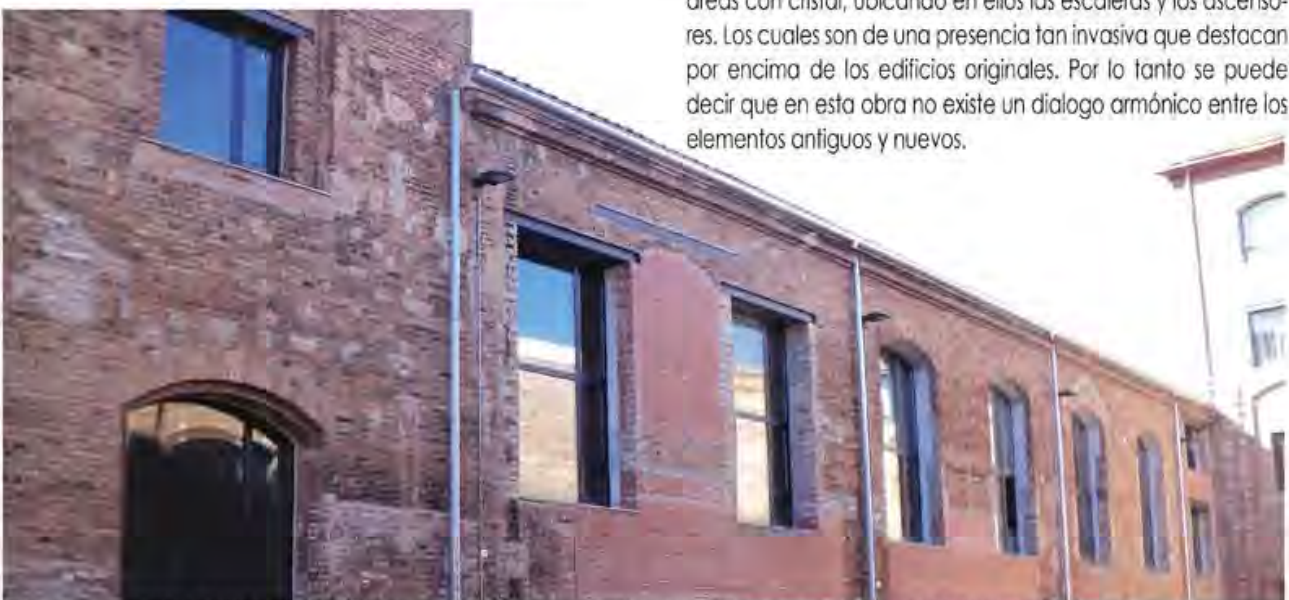
DETALLE DE LA FACHADA OESTE DEL PASAJE INTERIOR, DONDE SE PUEDE APRECIAR LA DIFERENCIA ENTRE LAS VENTANAS ORIGINALES Y LAS NUEVAS
