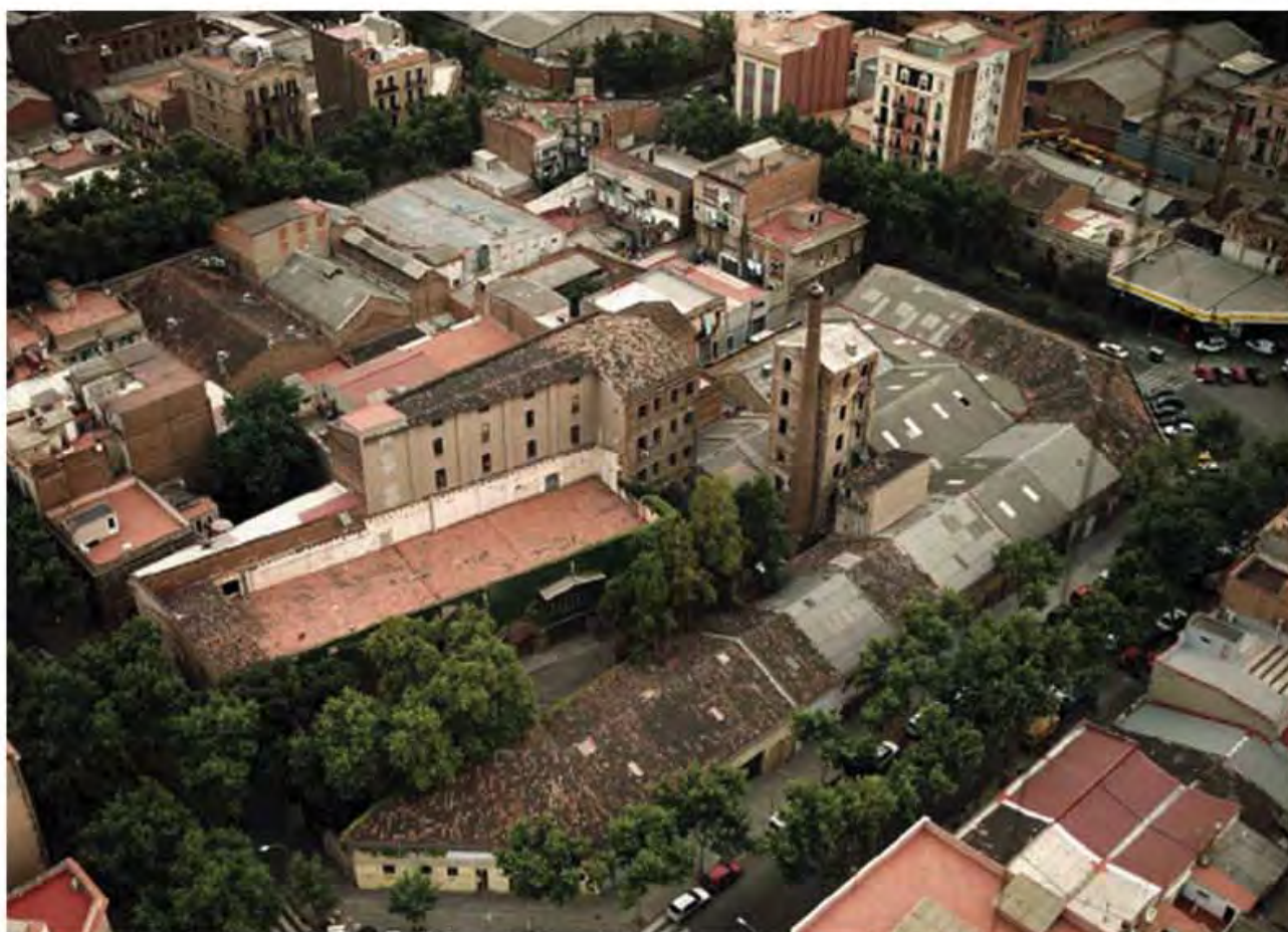
VISTA AÉREA DE LA FABRICA ANTES DE LA REHABILITACIÓN.
