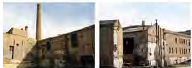
VISTAS EXTERIORES DE LAS NAVES EN CAN FRAMIS ANTES DE SU REHABILITACIÓN
