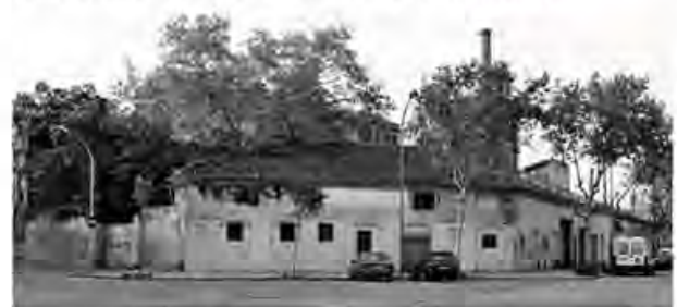
IMAGEN DE LOS EDIFICIOS DE LA FÁBRICA DESDE LA CALLE CIUTAT DE GRANADA.
