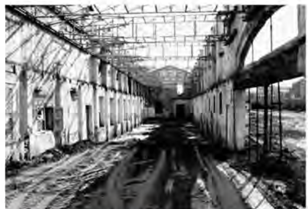
VISTA INTERIOR DE UNA DE LAS NAVES EN CAN FRAMIS ANTES DE SU REHABILITACIÓN
