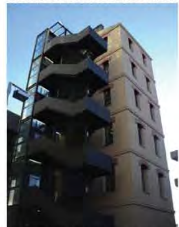
CUBO DE ESCALERAS Y ASCENSORES EN EL PROYECTO CAN GILI VELL
